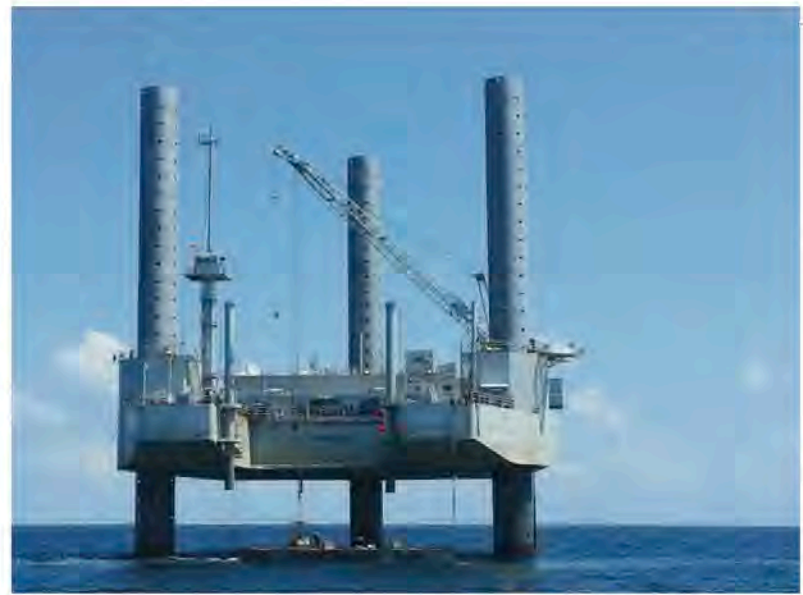
Mobile Offshore Production Unit (MOPU) diubah suai dan dinamakan Pangkalan Laut TUN SHARIFAH RODZIAH (PL TSR)
